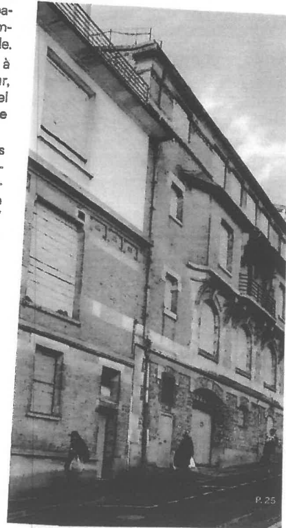
Le bâtiment du vieux Pozzo.
