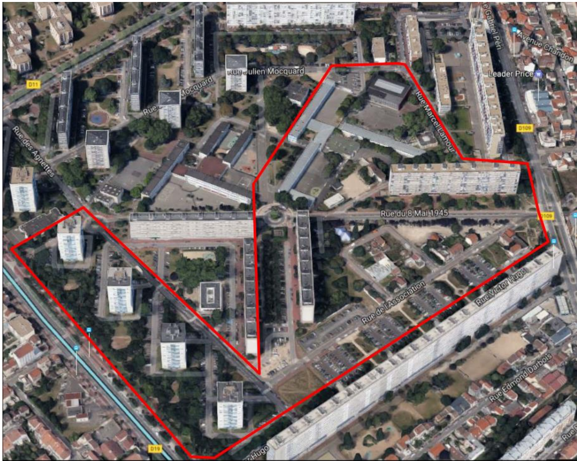
Vue aérienne du périmètre du projet
