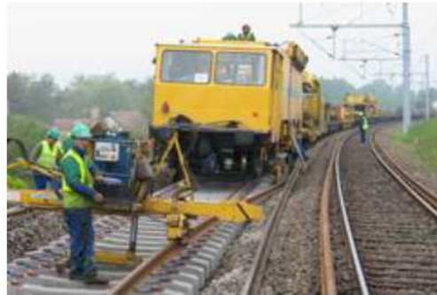
Longs Rails soudés sur traverses béton
