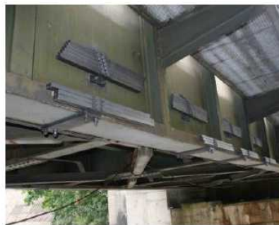
absorbeur sur platelage
