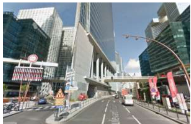
Vue de la Tour DEXIA depuis l'Est, sur le Boulevard Circulaire - Source : Google Street View
