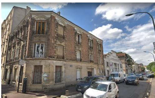
Immeuble mitoyen du projet avenue du Maréchal Leclerc
