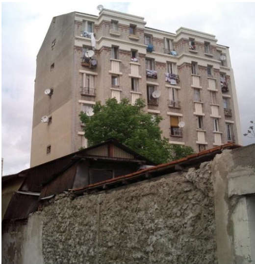
54 avenue Pierre-Brossolette, façade sur cour, bat B
