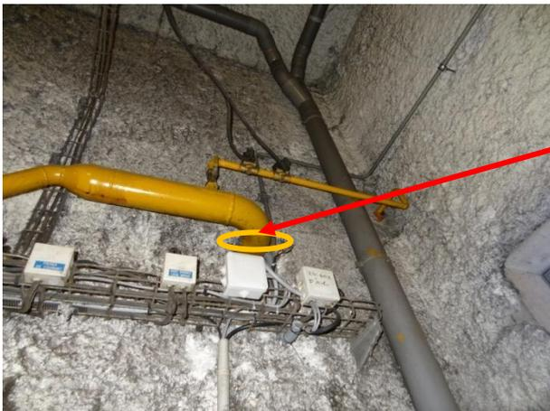
Récupérer une liaison au ceinturage à fond de fouille ou une câblette cuivrée présente à proximité de cette canalisation et la raccorder par un conducteur cuivre 16mm<sup>2</sup> minimum
