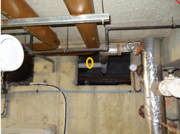
Récupérer la liaison câblette cuivrée présente à proximité de ces canalisations et les raccorder par un conducteur cuivre 16mm<sup>2</sup> minimum
