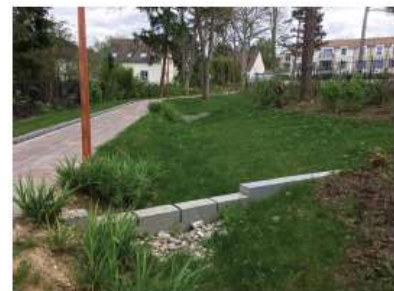
Référence de muret de bief en granit à Fourqueux (78)
