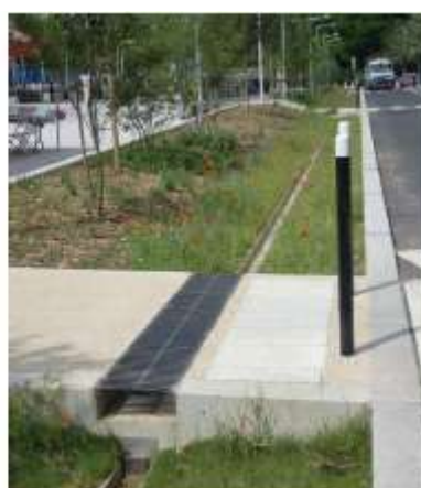
Exemple de liaison hydraulique par caniveau à grille (ici avec une canalisation supplémentaire pour le transit du débit de fuite) à La Courneuve (93)
