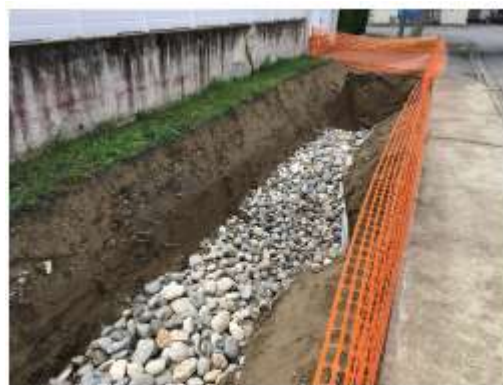
Tranchée drainante en cours de réalisation au fond d'une noue
