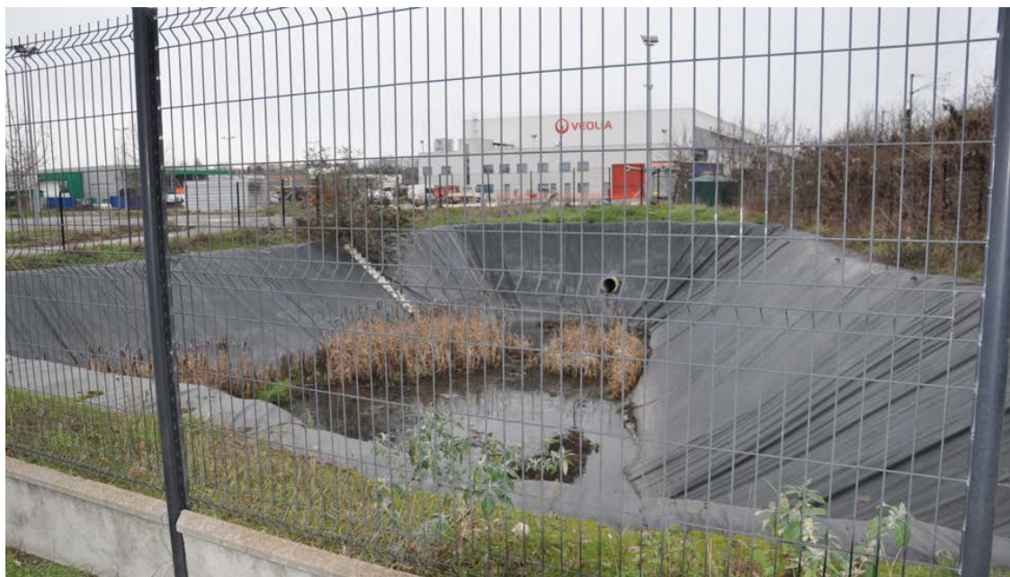
Photo : Bassin d'orage existant (26-01-2021)
