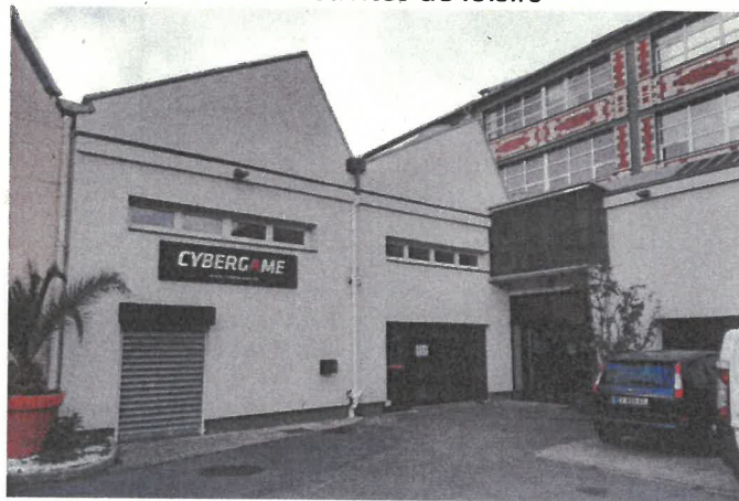
IMIE: Deux bâtiments conservés en dehors de la DUP- activités de loisirs
