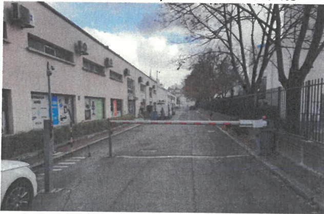
IMIE – voie d'accès, barrière de sécurité
