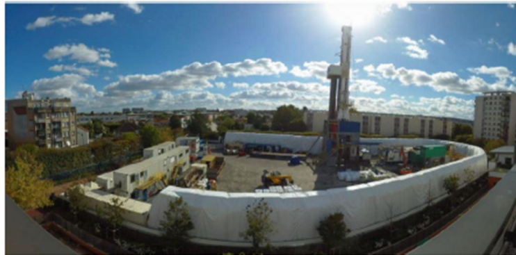
Figure 2 : Chantier de forage à Rueil-Malmaison (Septembre 2021, ENGIE Solutions)
