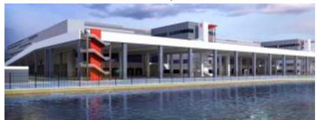
Vue des quais au rez-de-chaussée en façade sud
